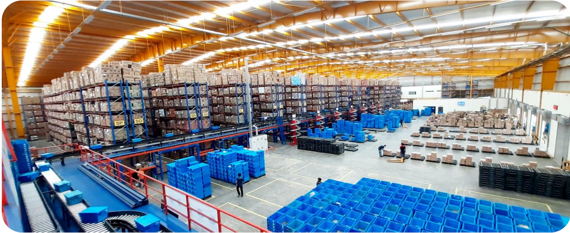
Warehouse in Bitung (Cikupa, Tangerang)
